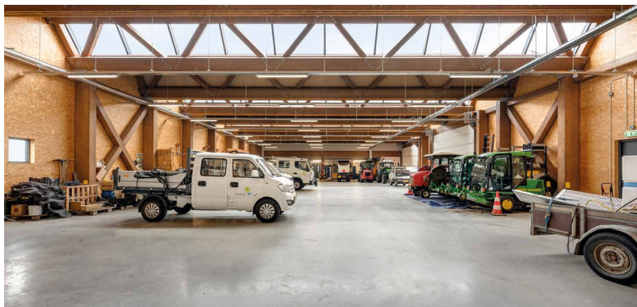
Houten overspanning gemeentewerf Nieuwkoop.
